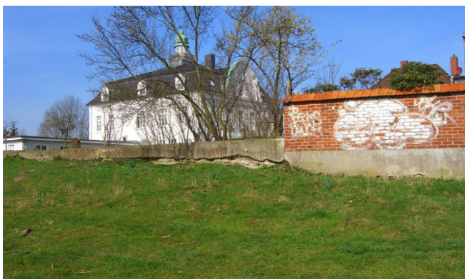
Abb. 56: Rückseite des Rathauses vor der Baumaßnahme
