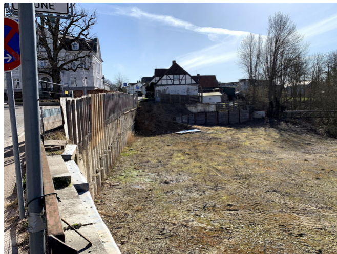
Abb. 62: Errichtung Bohrpfehlwand vor Neubau
