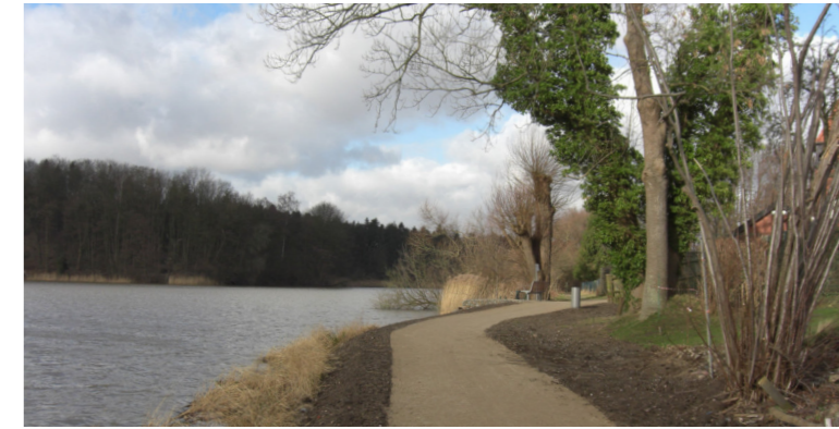
Abb. 41: Rundwanderweg in der Bauphase
