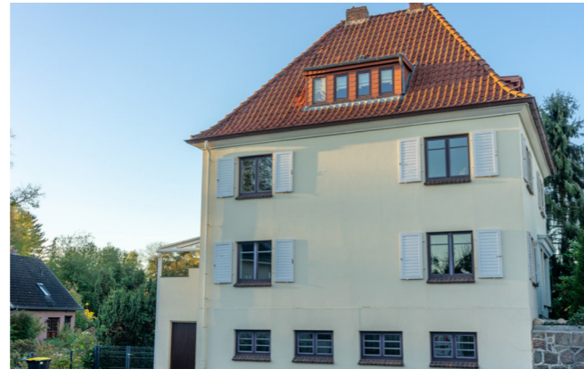
Abb. 74: Matthias-Claudius-Straße 7 nach Modernisierungs- und Instandsetzungsmaßnahme
