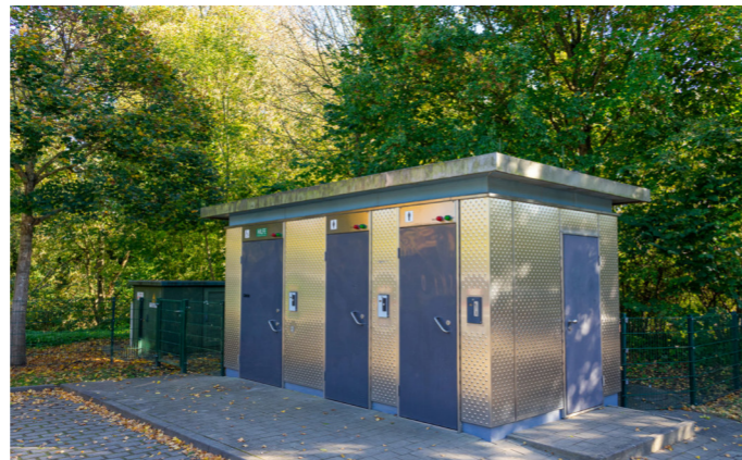
Abb. 16: Öffentliches Toilettenhäuschen auf dem Karpfenplatz
