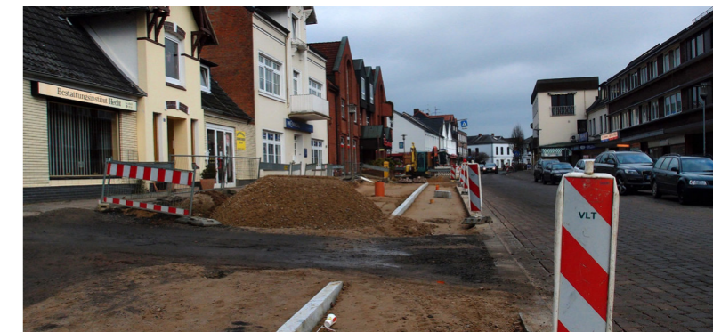
Abb. 64-65: Paul-von-Schoenaich-Straße vor und während der Baumaßnahme
