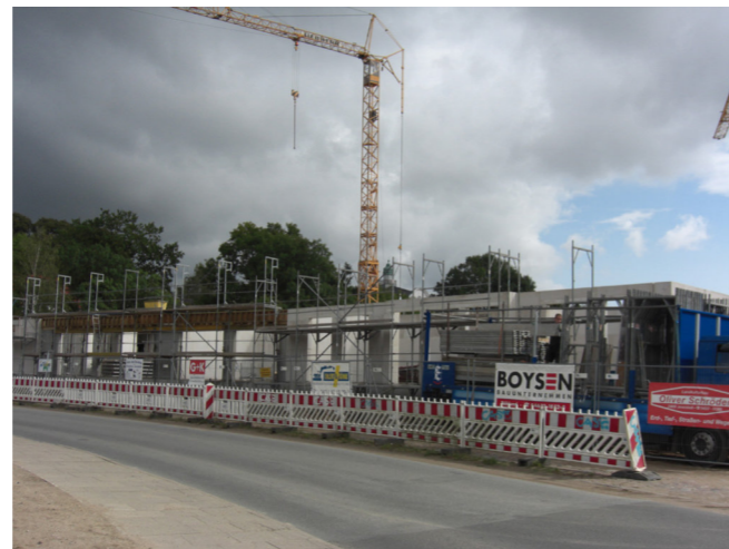
Abb. 30: Seniorenwohnanlage in der Bauphase
