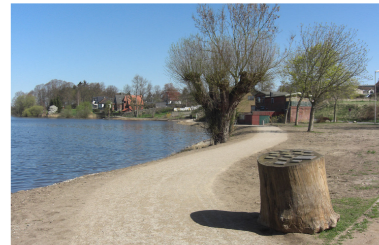
Abb. 42: Rundwanderweg in der Bauphase
