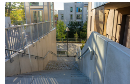
Abb. 39: Treppenanlage zwischen Mühleninsel und Rathausvorplatz
