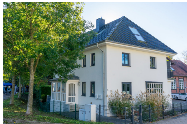
Abb. 75: Klosterstraße 3 nach Modernisierungs- und Instandsetzungsmaßnahme
