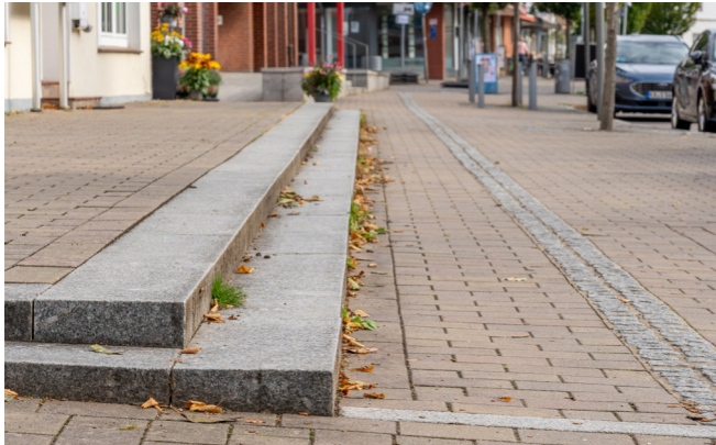
Abb. 68: Paul-von-Schoenaich-Straße nach Baumaßnahme
