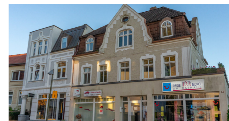
Abb. 73: Nord-Ansicht Paul-von-Schoenaich-Straße 16 nach Instandsetzungs- und Modernisierungsmaßnahmen
