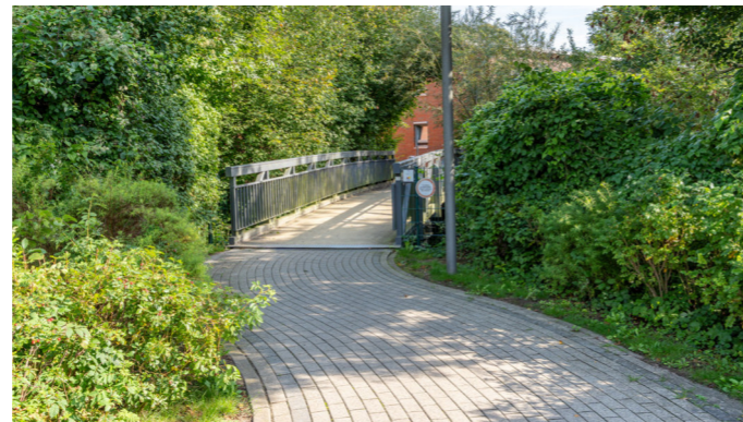
Abb. 17: Wegeverbindung zwischen Karpfenplatz und Mühleninsel
