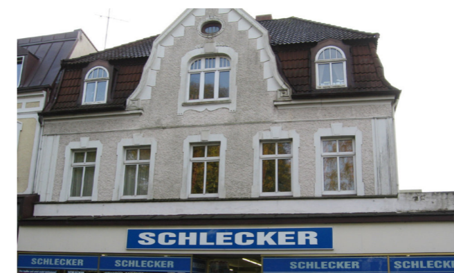
Abb. 72: Nord-Ansicht Paul-von-Schoenaich-Straße 16 vor Instandsetzungs- und Modernisierungsmaßnahmen
