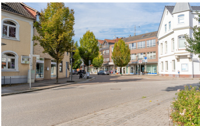
Abb. 70: Kreuzung Bahnhofstraße / Neuhöfer Straße / Paul-von-Schoenaich Straße nach der Sanierung
