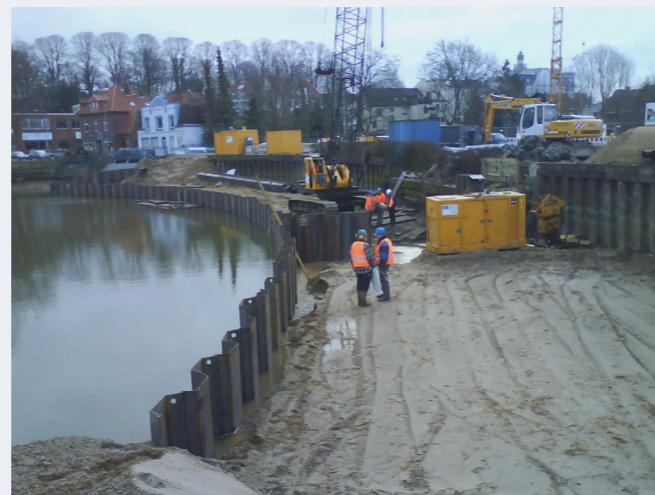
Abb. 20-21: Östliche und westliche Seepromenade während der Bauphase
