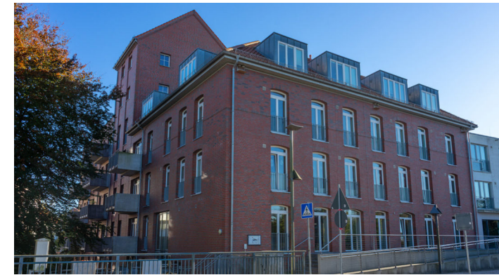
Abb. 31: fertiggestellte Seniorenwohnanlage (straßenseits)
