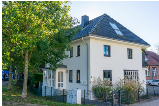
Abb. 75: Klosterstraße 3 nach Modernisierungs- und Instandsetzungsmaßnahme
