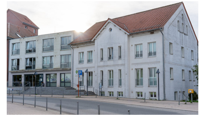
Abb. 32: fertiggestellte Seniorenwohnanlage (straßenseits)
