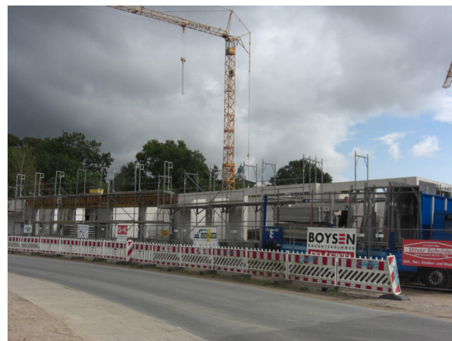
Abb. 30: Seniorenwohnanlage in der Bauphase
