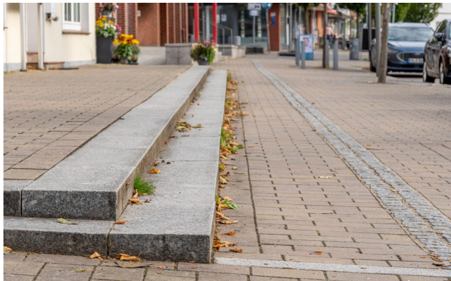
Abb. 68: Paul-von-Schoenaich-Straße nach Baumaßnahme
