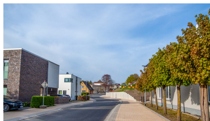
Abb. 48-49: Ahrensböcker Straße vor (links) und nach (rechts) der Sanierungsmaßnahme
