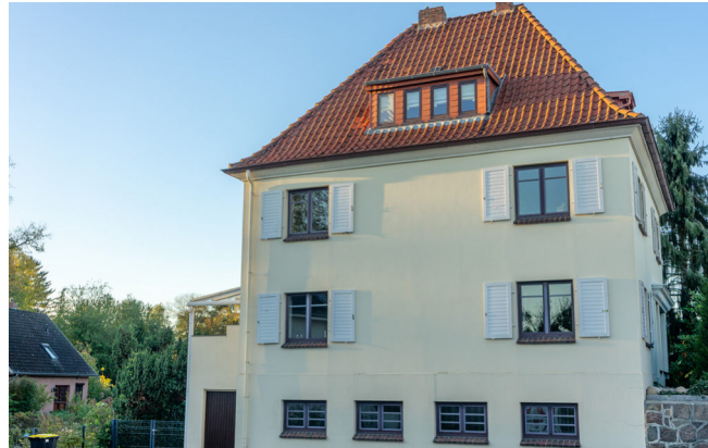
Abb. 74: Matthias-Claudius-Straße 7 nach Modernisierungs- und Instandsetzungsmaßnahme
