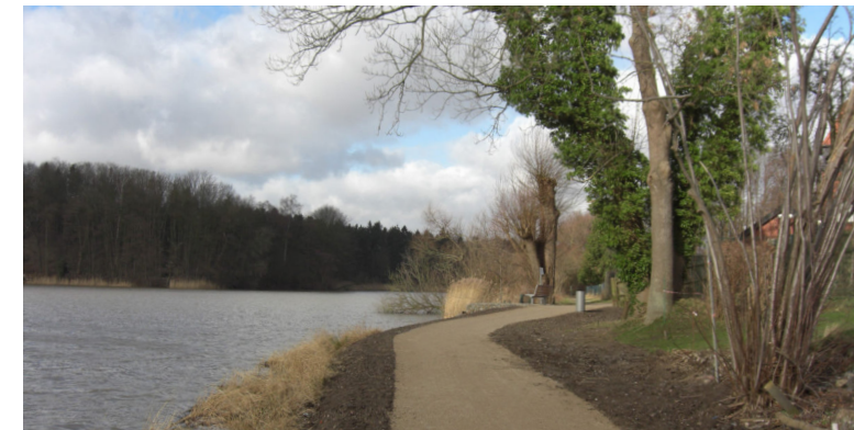
Abb. 41: Rundwanderweg in der Bauphase
