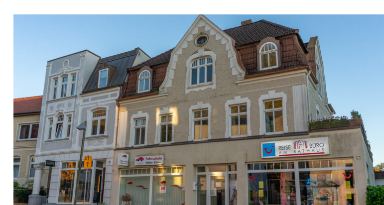
Abb. 73: Nord-Ansicht Paul-von-Schoenaich-Straße 16 nach Instandsetzungs- und Modernisierungsmaßnahmen
