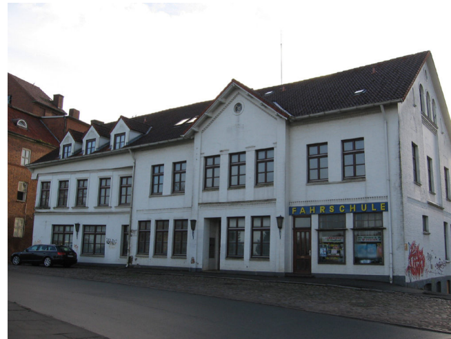
Abb. 28: ehemalige Wohn- und Gewerbeimmobilie
