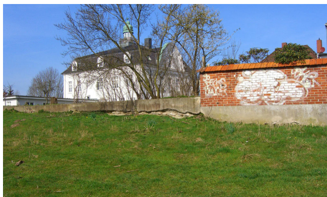
Abb. 56: Rückseite des Rathauses vor der Baumaßnahme
