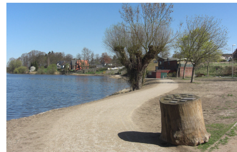
Abb. 42: Rundwanderweg in der Bauphase
