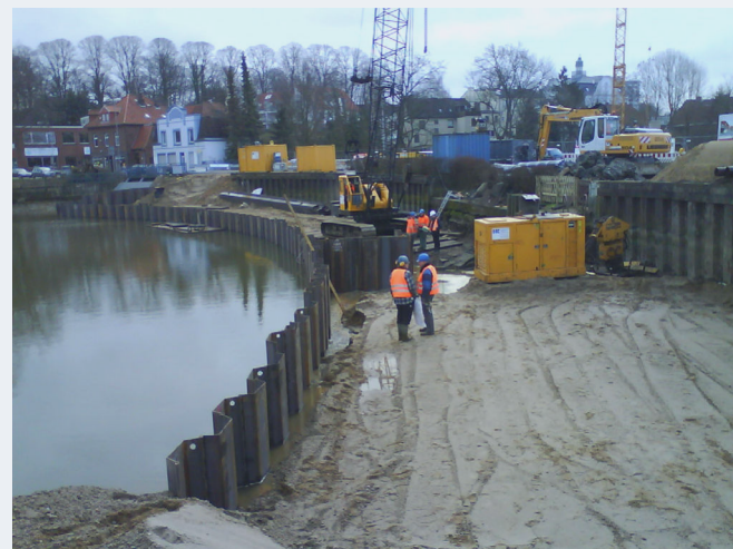
Abb. 20-21: Östliche und westliche Seepromenade während der Bauphase
