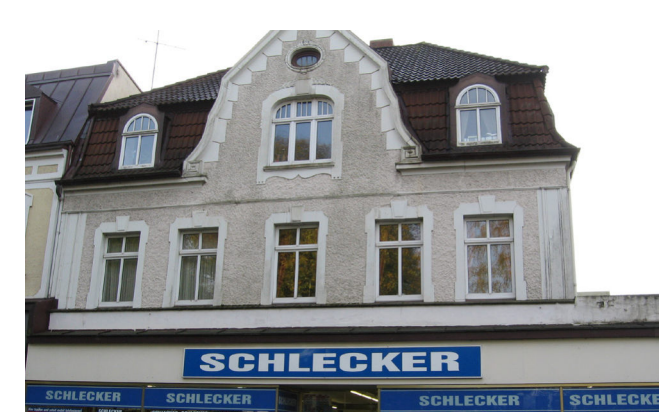
Abb. 72: Nord-Ansicht Paul-von-Schoenaich-Straße 16 vor Instandsetzungs- und Modernisierungsmaßnahmen
