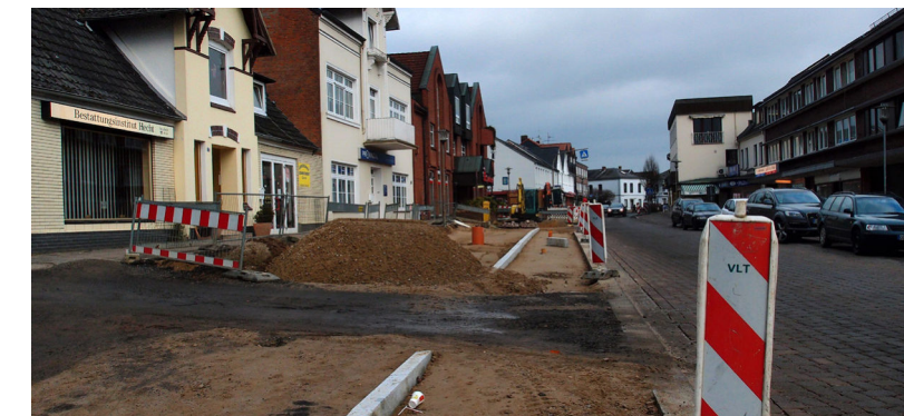
Abb. 64-65: Paul-von-Schoenaich-Straße vor und während der Baumaßnahme
