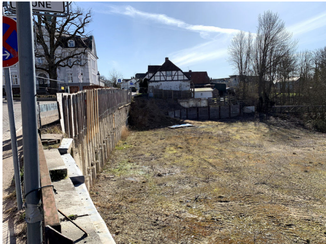
Abb. 62: Errichtung Bohrpfehlwand vor Neubau
