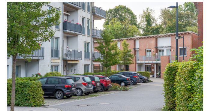
Abb. 33: fertiggestellte Seniorenwohnanlage (Rückseite)
